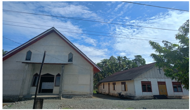
Gambar 1.2 Gedung GKLB Jemaat Elim Dowiwi.
