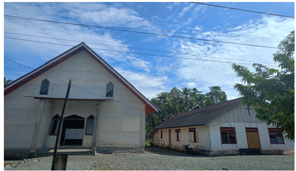
Gambar 1.2 Gedung GKLB Jemaat Elim Dowiwi.
